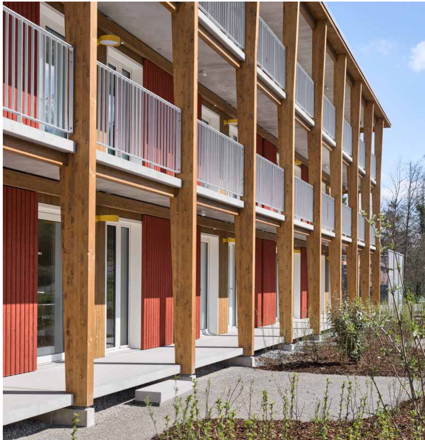
Die 60 Holzmodule für das Asylzentrum wurden von der Schönauer AG aus Rebstein (SG) mit einem hohen Vorfertigungsgrad an die Baustelle in Adliswil (ZH) geliefert.
