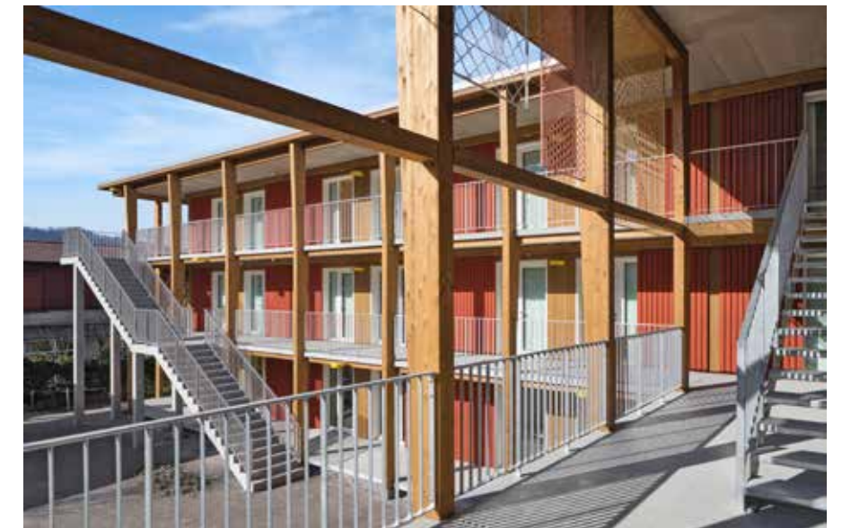
Die Brettchichtholzpfosten – auch sie kamen als fertige Elemente auf die Baustelle – zeugen mit ihren Anfräsungen, Konsolen und Knoten auf anschauliche Weise vom Kräftefluss und der Fügung der Teile.
