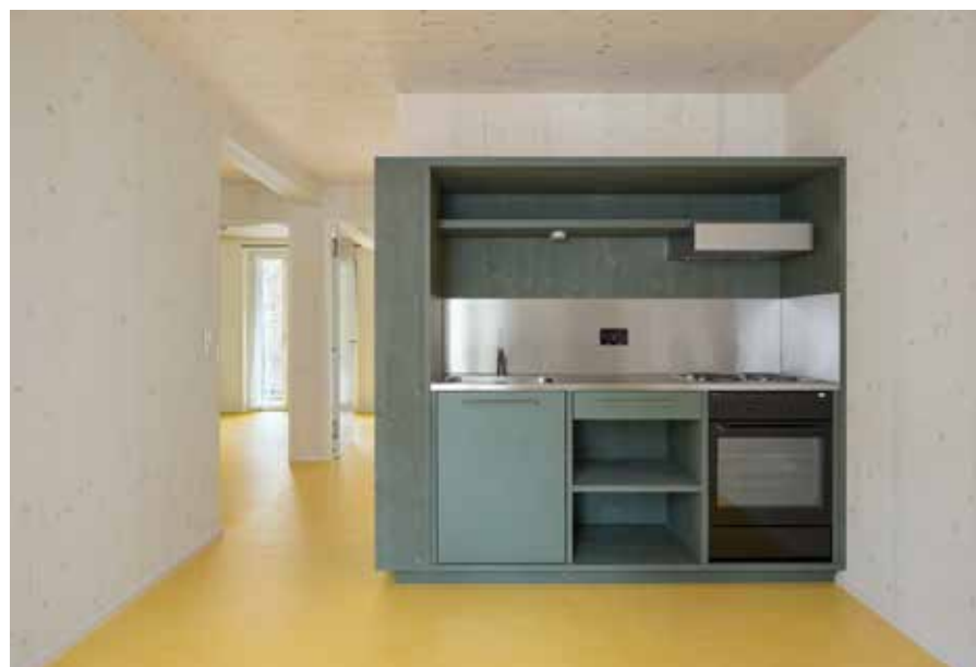
Im Innenbereich dominieren CLT-Platten (Brettschichtholz in Fichte/Tanne), deren Holz mit einer hell pigmentierten Öllasur behandelt wurde.
